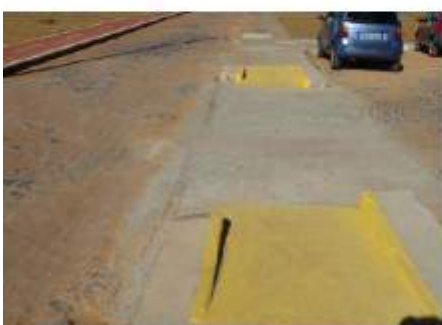
FOTO 6: Construção de rampas em
