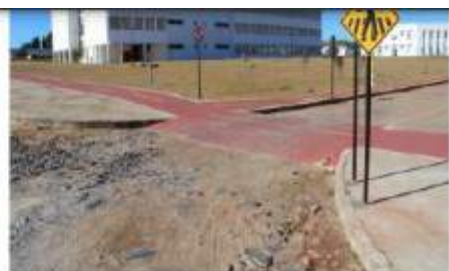
FOTO 4: Sinalização e faixa de pedestre em execução.
