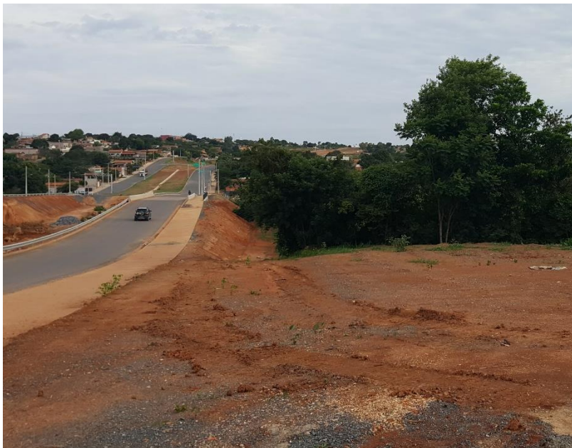
Figura 8. Pontes construídas sobre o Riacho Fundo
