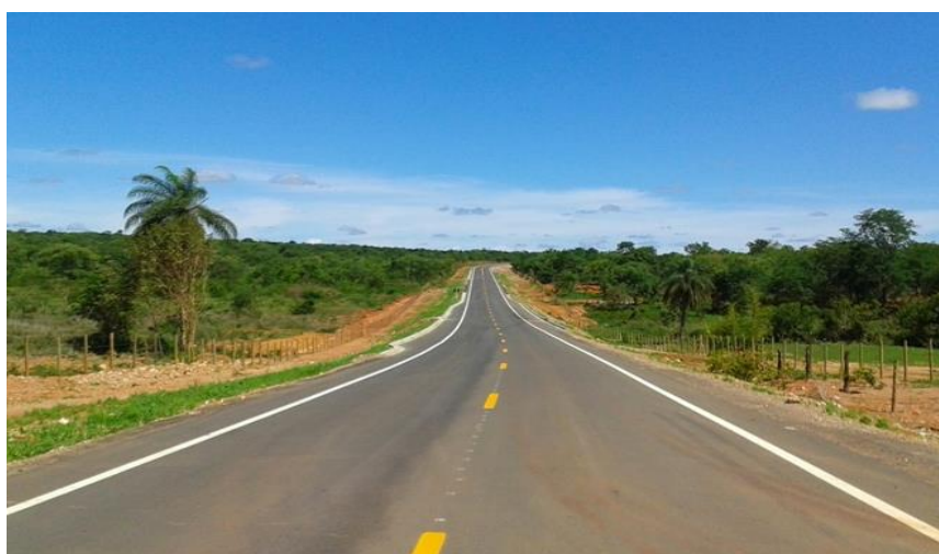
Figura 7. Pista da LMG 754 asfaltada.
